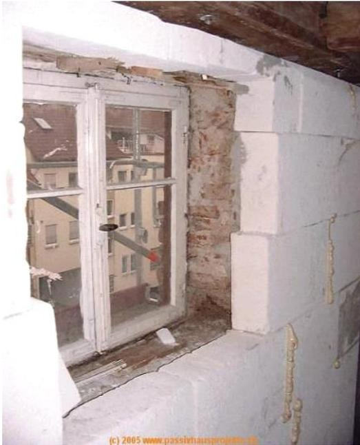
Abb. 1: Anbringen von Innendämmung
